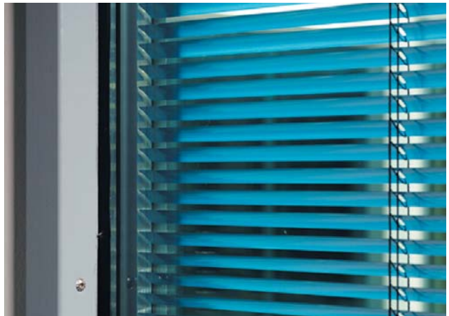
Zwischen den Isolierscheiben liegendes Raffstore
