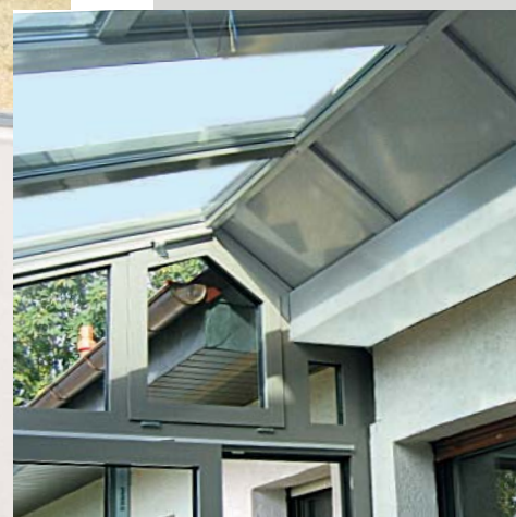
Beispiel Bauanschlüsse einer Dachkonstruktion
