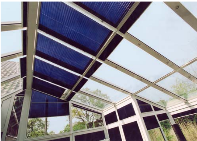
Faltstore unter Dach montiert
