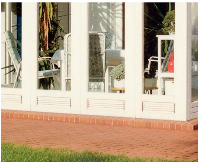
Unten montierte Dosiermehrfachlüftung
